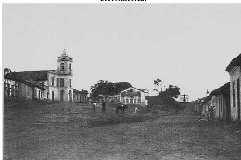
Fig. 9 - Entorno da Igreja, com a antiga delegacia e casa antigas em taipa de mão e ao fundo a capela, data desconhecida.
