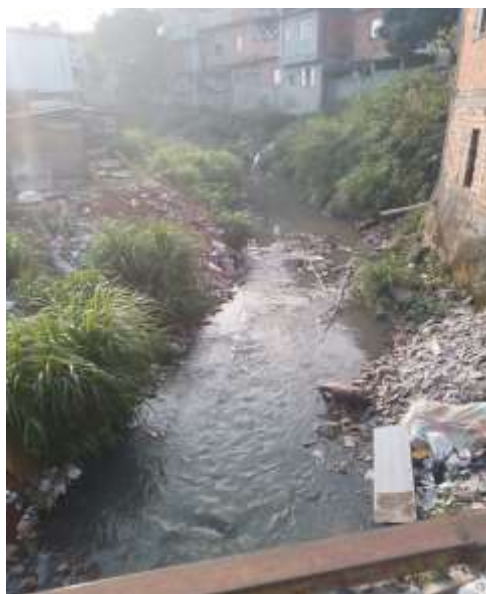
Foto 3: Esgoto e entulho a céu aberto
