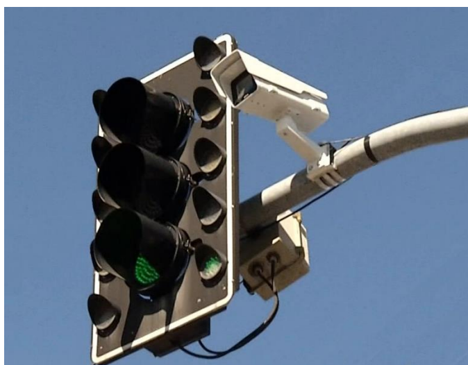
Figura 5 – Modelo de semáforo com câmera integrada
